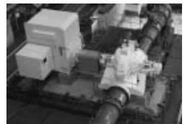
Fig. 3 大型両吸込渦巻ポンプ(電業社)
