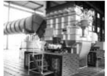
Fig.17 台湾大手化学会社向けIDF 1,200 kW （日本機械技術）
