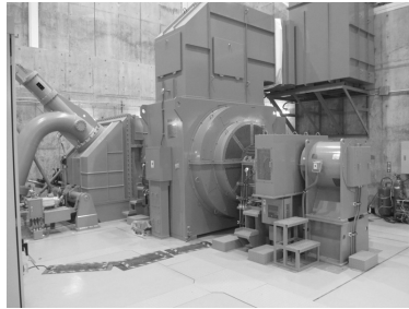
Fig. 7 片貝別又発電所 全景
