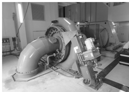
Fig. 10 七滝川第一発電所、水車
