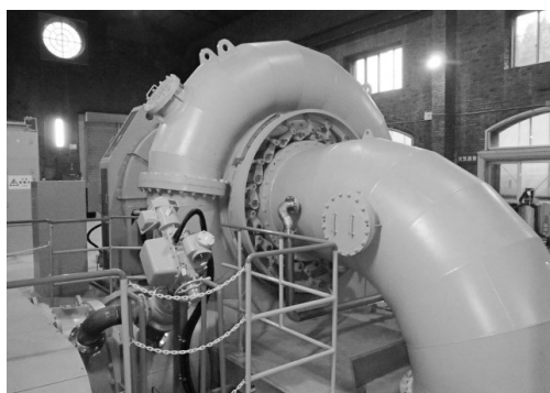
Fig. 8 碓発電所、水車（三菱マテリアル）
