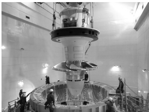
Fig. 7 秋葉第二発電所 ランナ吊込み（J-POWER [電源開発]）
