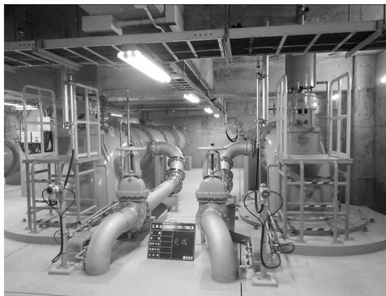
Fig. 2 仙台市役所荒井東雨水ポンプ場 立軸斜流ポンプ
