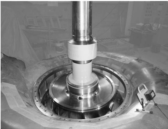
Fig. 5 高千穂発電所1号機 フランシス水車
