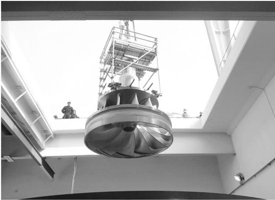
Fig. 4 秋葉第一発電所 ランナ吊込み
