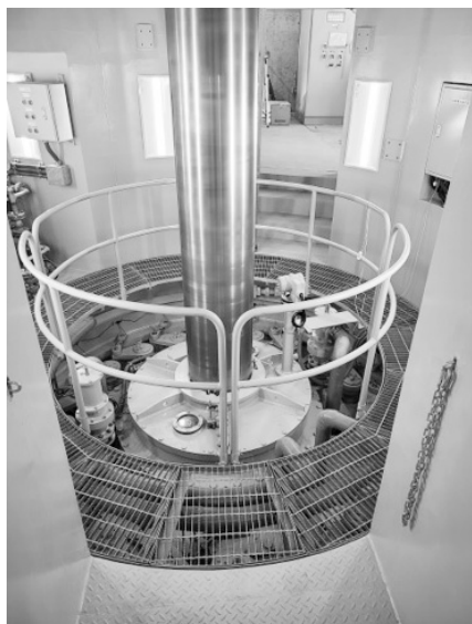
Fig. 3 竹田発電所 立軸カプラン水車
